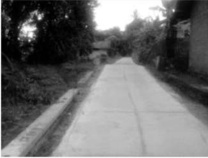
Jalan PNPM yang dibangun masyarakat Kecamatan Dukun, Kabupaten Magelang, Jawa Tengah.
