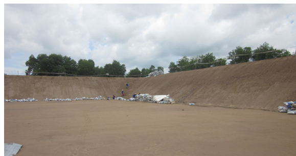
Gambar 2.14. Kolam yang Siap untuk Dilapisi Geo-membrane
