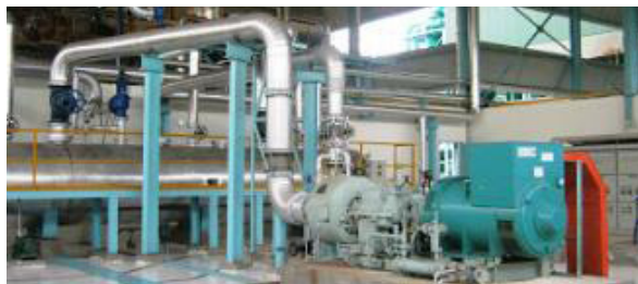
Gambar 3.9. Turbin Uap pada Pabrik Kelapa Sawit
