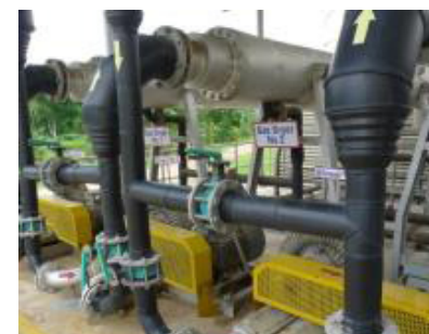
Gambar 2.4. Dehumidifier Biogas
