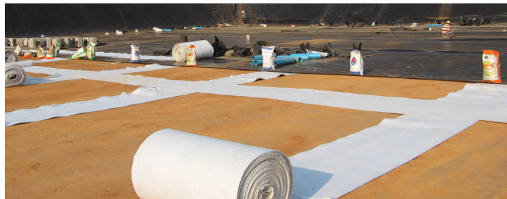
Gambar 2.17. Pemasangan Geo-composite
