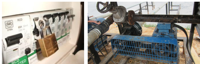
Gambar 2.33. Gembok Panel Listrik untuk Perlindungan Keselamatan (kiri), Penutup Mesin untuk Perlindungan dari Mesin yang Berputar (kanan)
