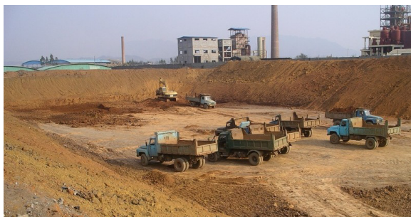
Gambar 2.13. Backhoe dan Bulldozer yang Digunakan Selama Pembangunan Kolam
