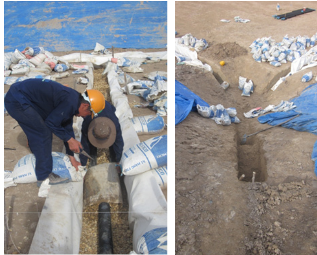
Gambar 2.15. Konstruksi Parit (kiri), Saluran Pengumpul Air (kanan)
