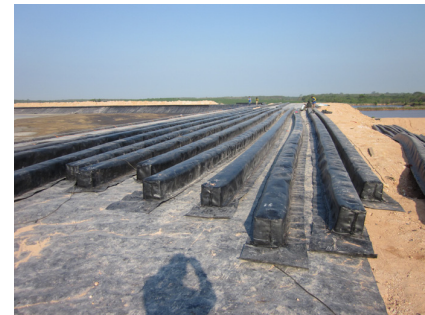
Gambar 2.21. Floater yang Terbuat dari EPS Dibungkus HDPE Geo-membrane
