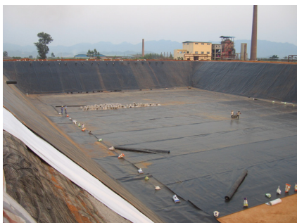
Gambar 2.18. Pemasangan Liner
