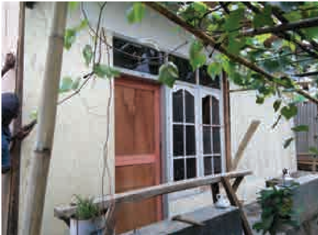
Penggunaan jendela dan pintu bekas pada Huntara Setara Tahap 5 Finishing
